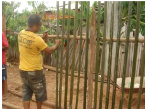
Figura 3. Construção de cercas com o babaçu no Bico do Papagaio. Fonte: Iphan Tocantins, 2011.
