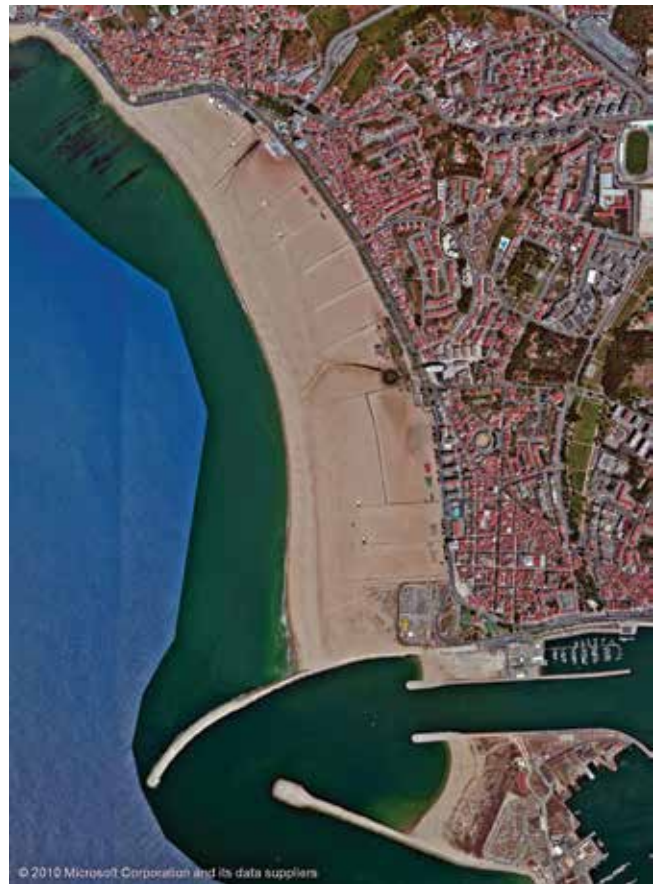
Figura 8. Fotografia aérea dos molhes do Porto da Figueira da Foz. Observe-se a acumulação de areia junto ao molhe Norte e a nova extensão desta praia, 2010 (Microsoft Corporation, montagem de A. Mota Lopes).
